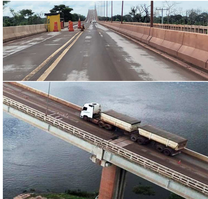
Em dezembro o Governo do Estado, através da Agesul, deu início aos serviços de reparo e manutenção na ponte sobre o Rio Paraguai devido o surgimento de novas patologias na infraestrutura e ao aumento expressivo do fluxo de veículos pesados e do excesso de velocidade registrado.
