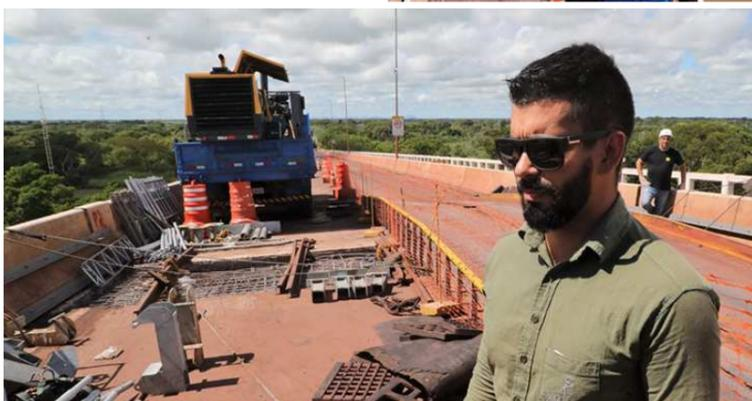
O engenheiro civil Lauro Peres explica: a plataforma servirá para a colocação de novas placas de aço e concretagem
