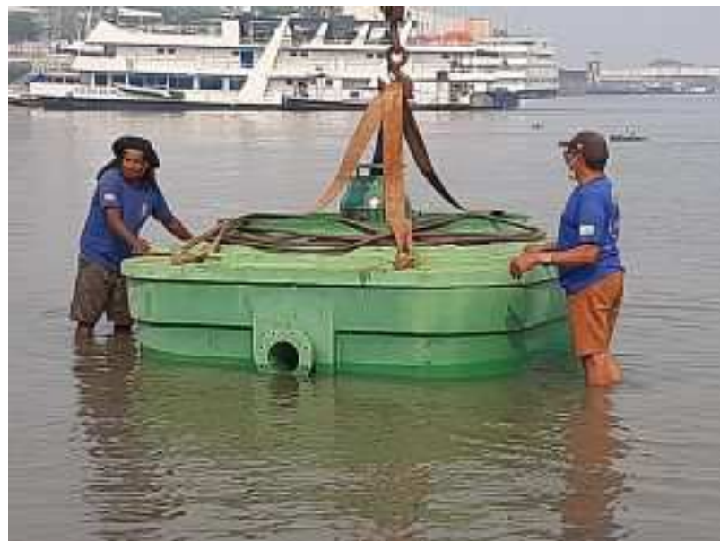
Instalação de bombas no Rio Paraguai em Corumbá no ano de 2021
