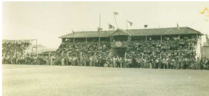
Primeira estrutura do estádio Arthur Marinho.
