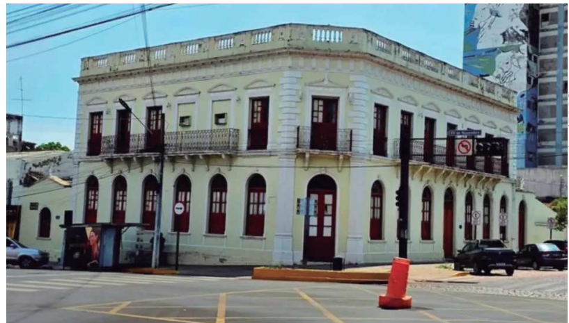
Execução das obras de restauração do prédio da antiga Prefeitura de Corumbá. O valor estimado para o investimento é de R$ 5.091.322,73.
