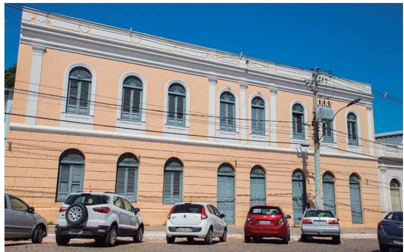
Execução das obras de restauração do antigo Hotel Internacional. O investimento estimado é de R$ 3.834.292,75.
